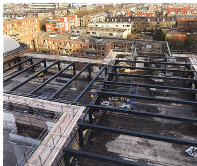
8. Staalconstructie nieuwe verdiepingvloer in opbouw.
