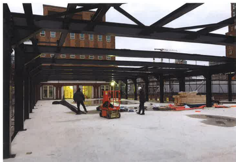
9. Dakconstructie in opbouw.
