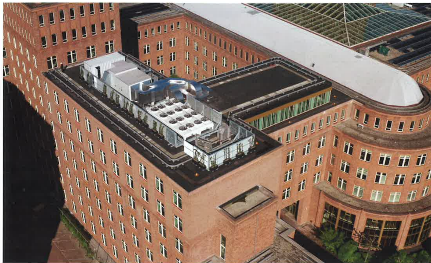
1. Gerealiseerde optop met op de voorgrond bouwdeel C2 (met installaties op het dak) en loodrecht hierop, met terugliggende glazen gevel, bouwdeel B2.
